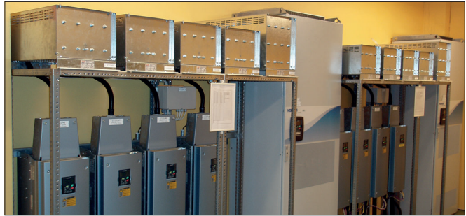
Cressall DBR Series bromsmotstånd installerade ovanför frekvensomformarna på ett pappersbruk.
